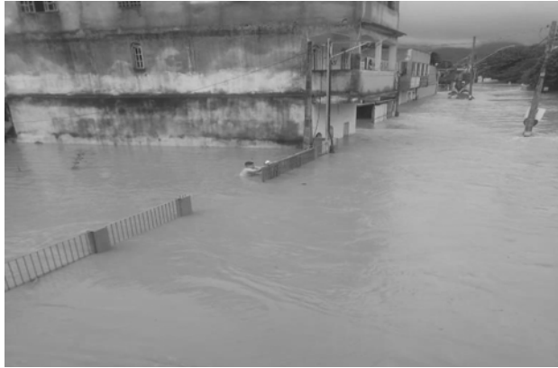
Figura 2 - Rua Antônio Freire no período de fortes chuvas
